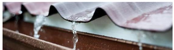
Figura 7. Captación de cubiertas mediante canaletas
